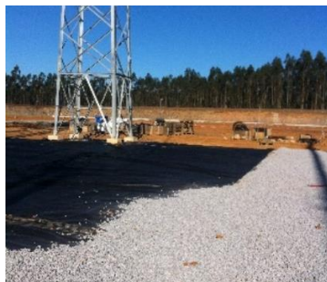
Colocação de gravilha
