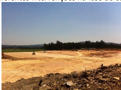
Movimentação de terras para criação da plataforma
