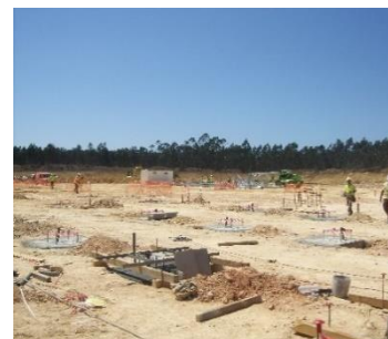
Maciços para colocação das estruturas metálicas
