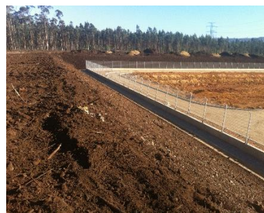
Colocação de terra vegetal nos taludes
