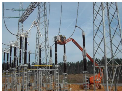
Montagem de equipamento
